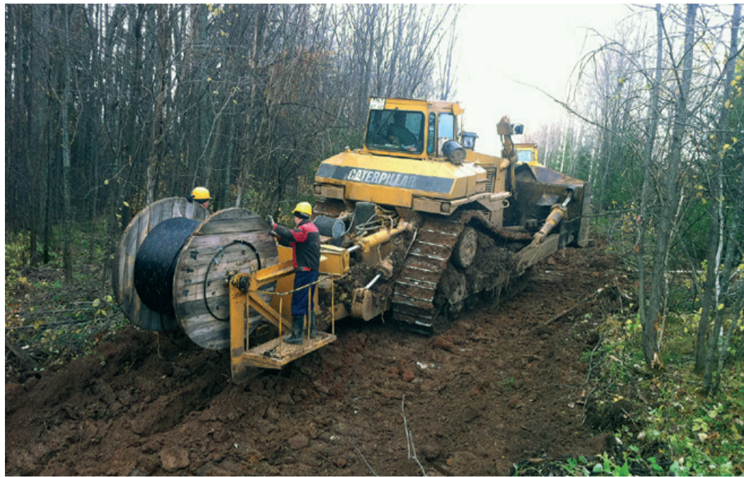
Будни связистов. Идет прокладка ВОЛС на газопроводе Челябинск–Петровск
