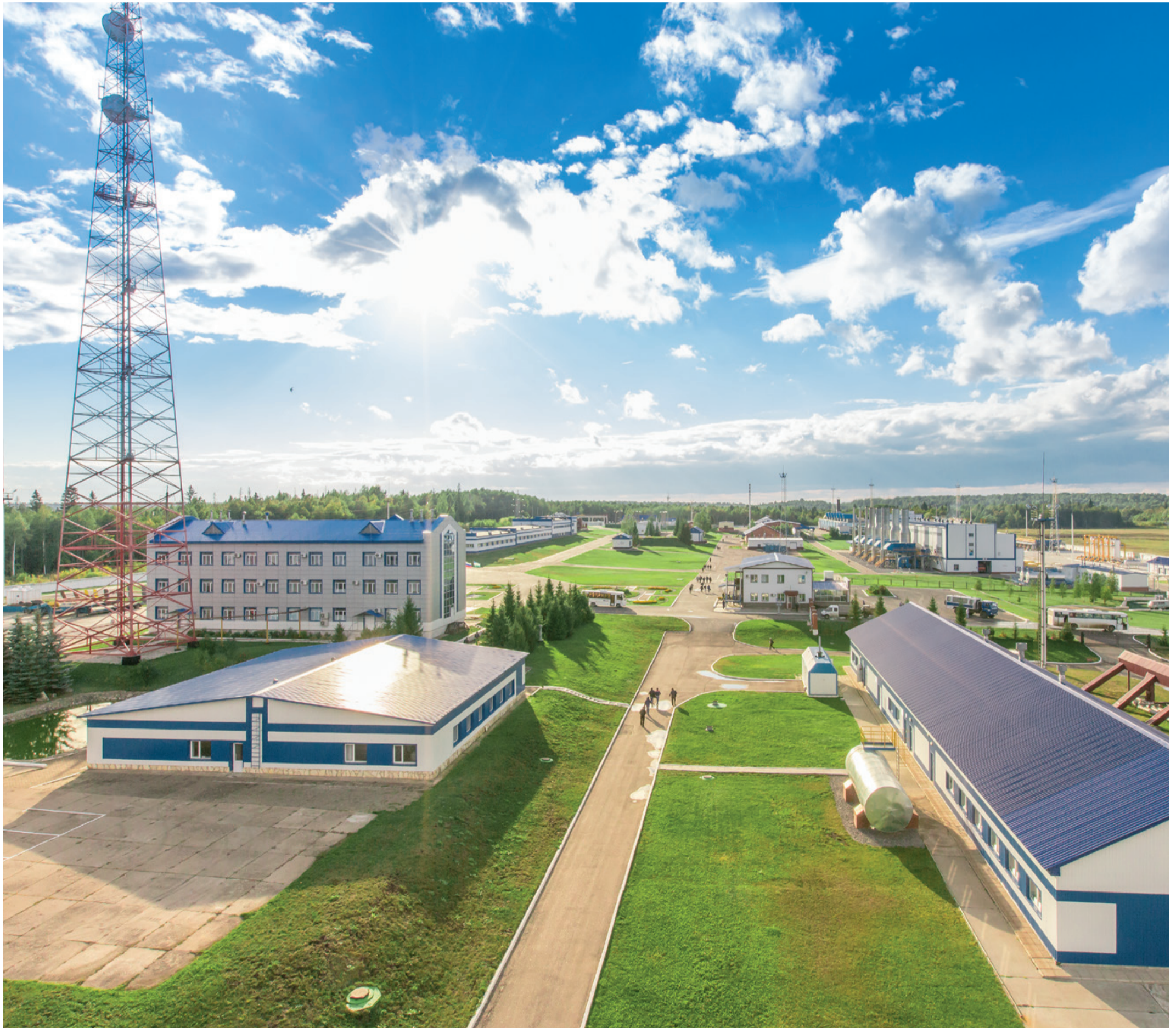
Радиорелейная станция № 13 Полянского ЛПУМГ. Фото Романа Шумного
