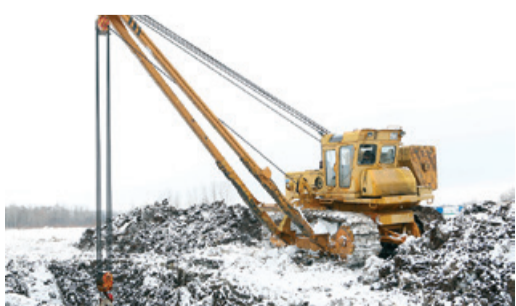
РЕМОНТ ПО-ЗИМНЕМУ Стр. 2
